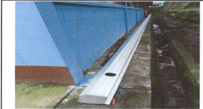
Foto 8: Sustitución de canal de metal
