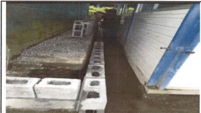
Foto 10: Reparación de banquetas de concreto
