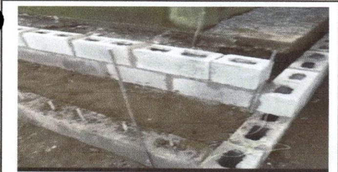
Foto 11: Reparación de muro de contención
